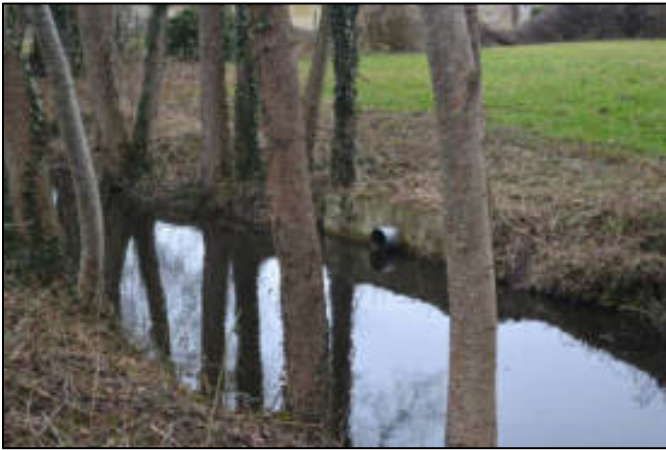
Figure 5, exutoire des eaux pluviales – environ 20m en amont du lavoir
