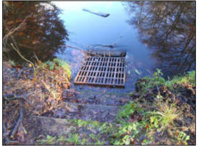
Figure 2, grille de surverse de l'étang
