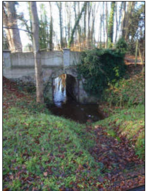
Figure 4, pont de pierre en aval la surverse.
